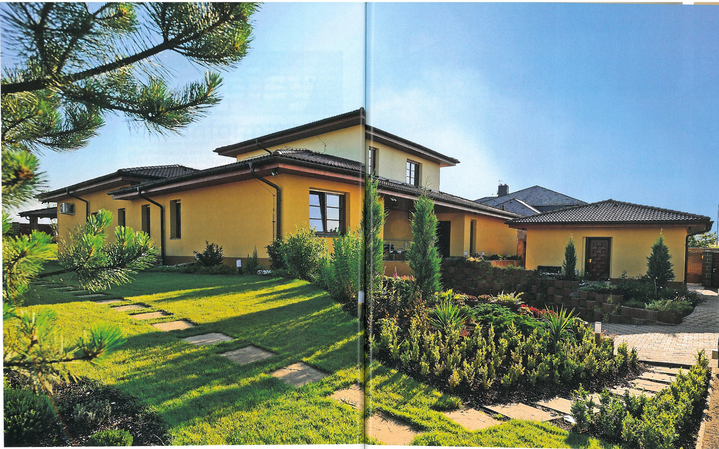
Pohled na vstupní část. Díky kompozici s ustupujícím horním podlažím a nízkými sedlovými a pultovými střechami dům příliš neční do okolí ani nedává najevo svou rozlehlost. Úprava předpolí naznačuje důraz na terénní úpravy a pečlivé zakomponování zahradních prvků
